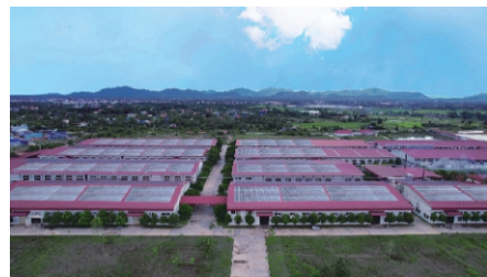
HSD柬埔寨工厂太阳能发电系统
