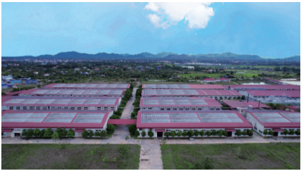
HSD柬埔寨工厂太阳能发电系统
